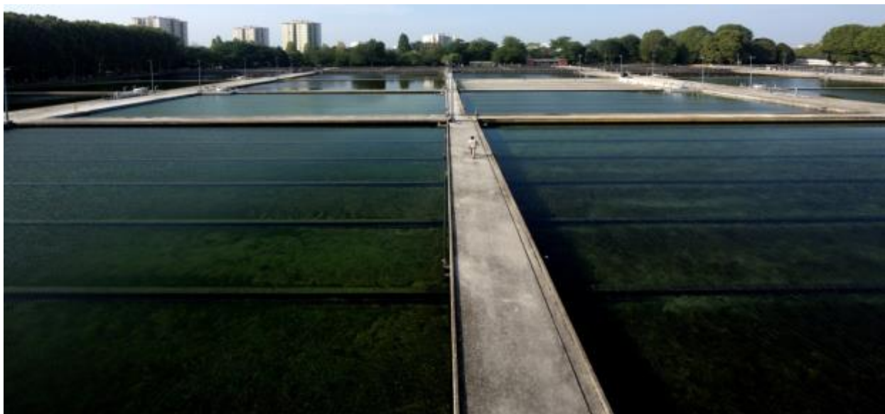
Usine de Joinville Filtres lents
